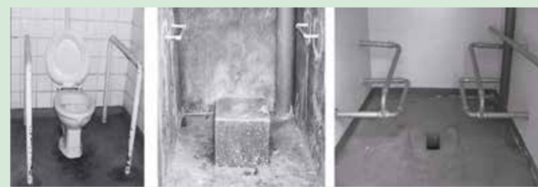
Різні приклади поручнів, встановлених біля унітазу
